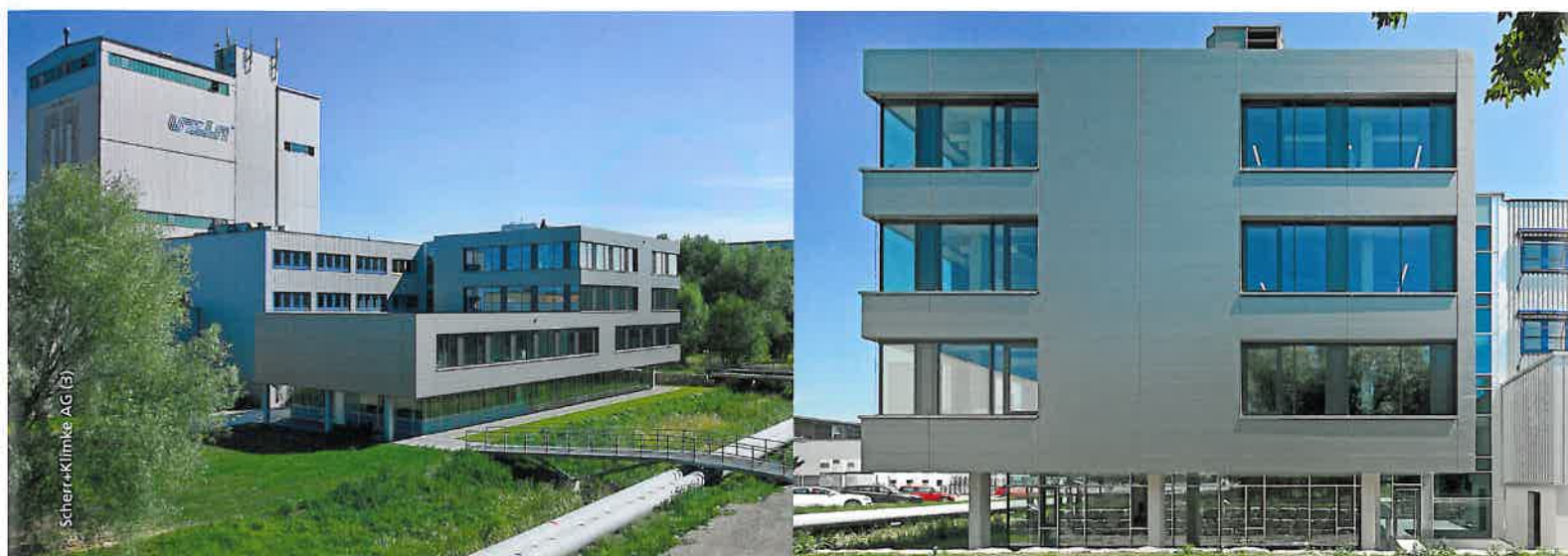
Die Staffelung von zwei auf vier Geschosse erhält die Blickbeziehungen vom benachbarten Uzin Utz Forum für Veranstaltungen in das Werksgelände.
