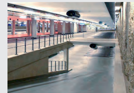
Parkhaus am Rathaus, Ulm in Kooperation mit Hochstrasser Architekten, Ulm
